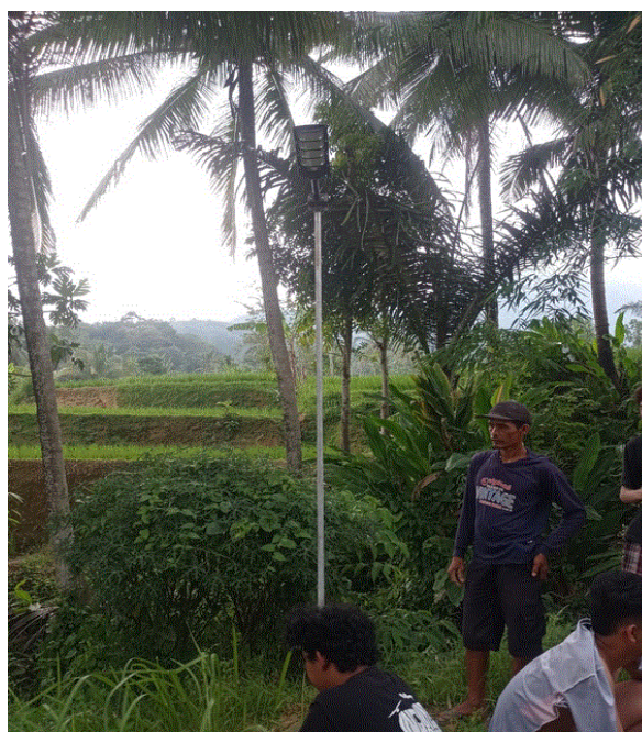
Gambar. 8. Pembuatan dudukan tiang lampu
