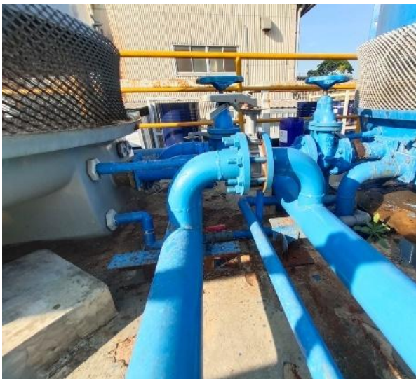
Gambar 6. Penyatuan pipa outlet di titik 1
